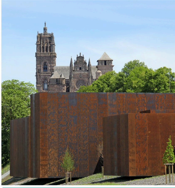
Exposition sur des bâtiments récemment construits
