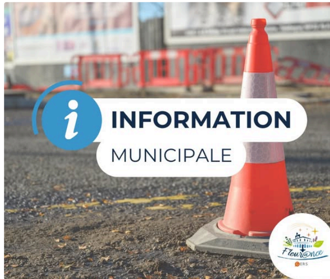
Travaux de l'avenue Martial Cazes
