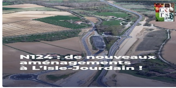
Travaux N124 : une nouvelle étape
