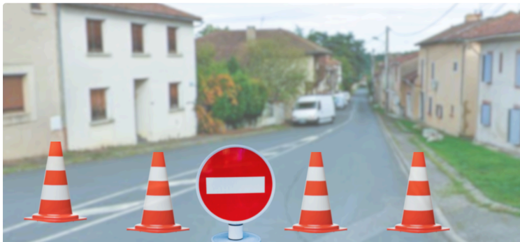
Interdiction de stationnement et circulation rue du Cubet et rue Saint Jean
