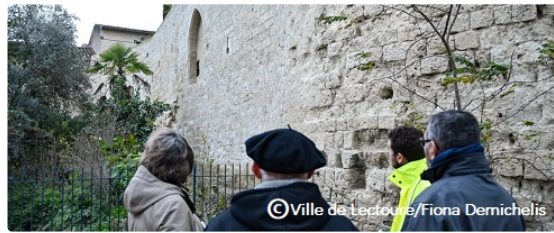
Fin de travaux du chantier de la Tour du Bourreau
