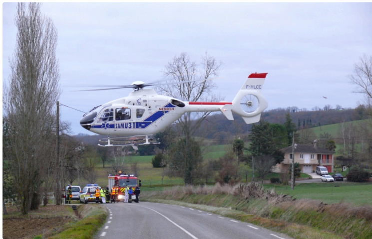
Un ouvrier passe au travers d'une toiture, il est hélicoptéré au CHU de Purpan
