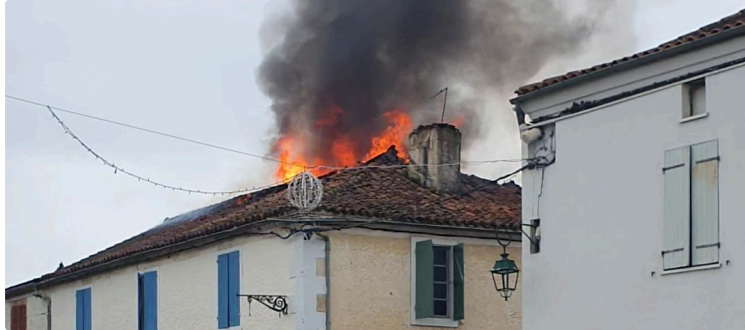
Important incendie à Miélan
