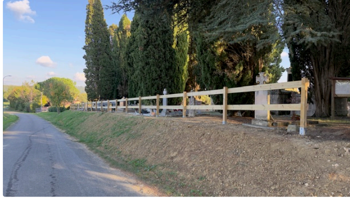
Travaux d'aménagement au cimetière
