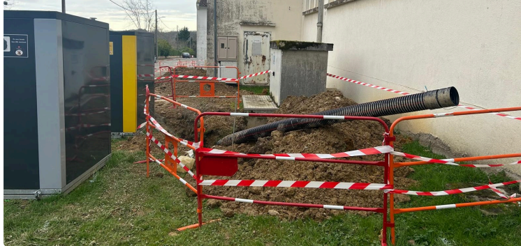
Lancement des travaux du Pôle Pluridisciplinaire de Santé, le PPS de Miélan
