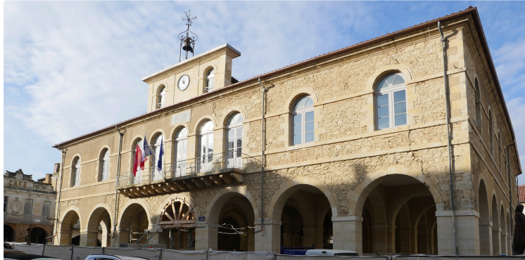
Travaux hôtel de ville
