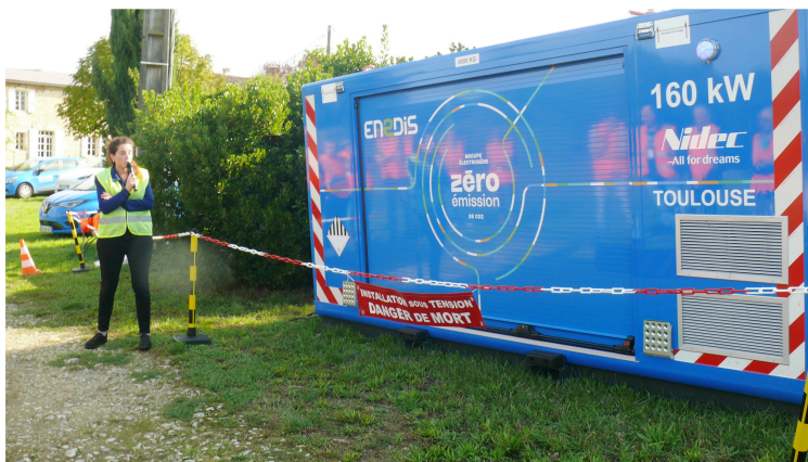
Enedis alerte ses clients contre une nouvelle vague de démarchages frauduleux
