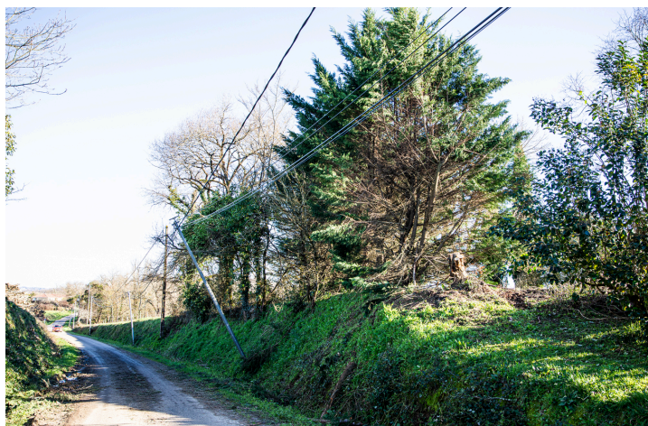
La route est dégagée, la souche du cèdre est, provisoirement remise en place, mais le poteau téléphonique a besoin de secours
