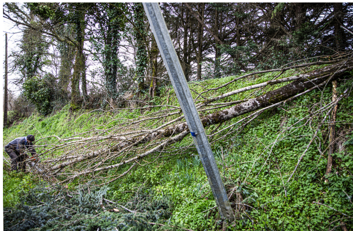
C'est le tour d'un autre arbre sur le même chantier d'être dégagé
