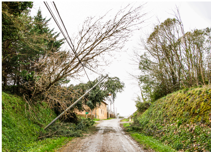
Le même chantier vu de l'autre côté ; le plus gros arbre tombé est un cèdre
