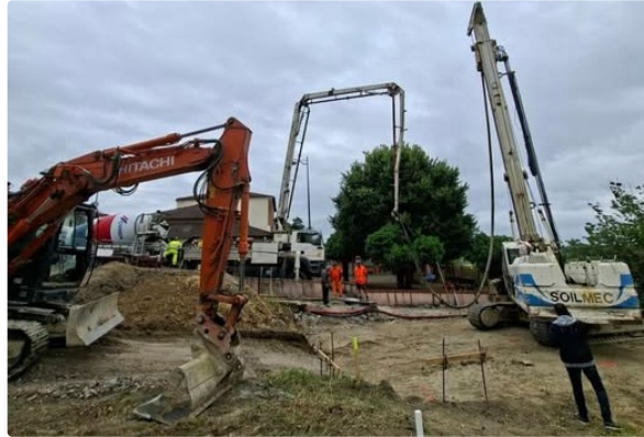
Les travaux débutent à l'école
