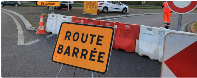
Travaux sur la rocade d'Auch D1124, nuit du 9 au 10 juillet
