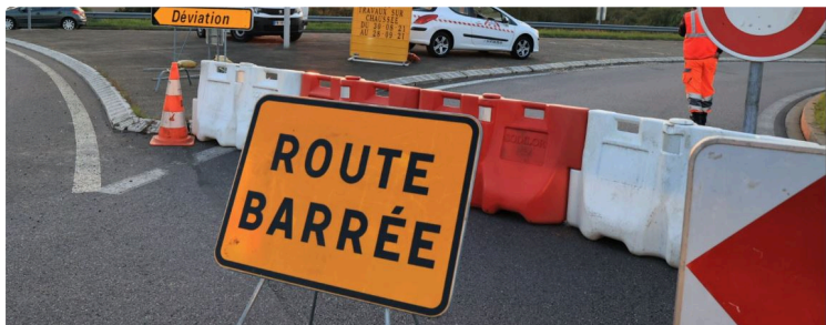
Rénovation des routes départementales : Restrictions de circulation sur la RD 626 du 20 au 28 juillet
