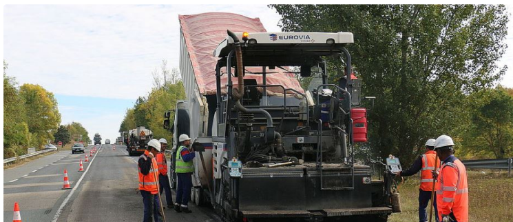
Travaux sur la RD 924 : des perturbations de circulation entre le 27 juillet et le 6 août
